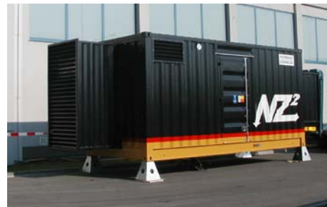
Kompaktný ISO kontajner pre inštaláciu energocentra v exteriéri je vítanou voľbou, ak sa v objekte pôvodne nepočítalo s umiestnením záložného zdroja.
