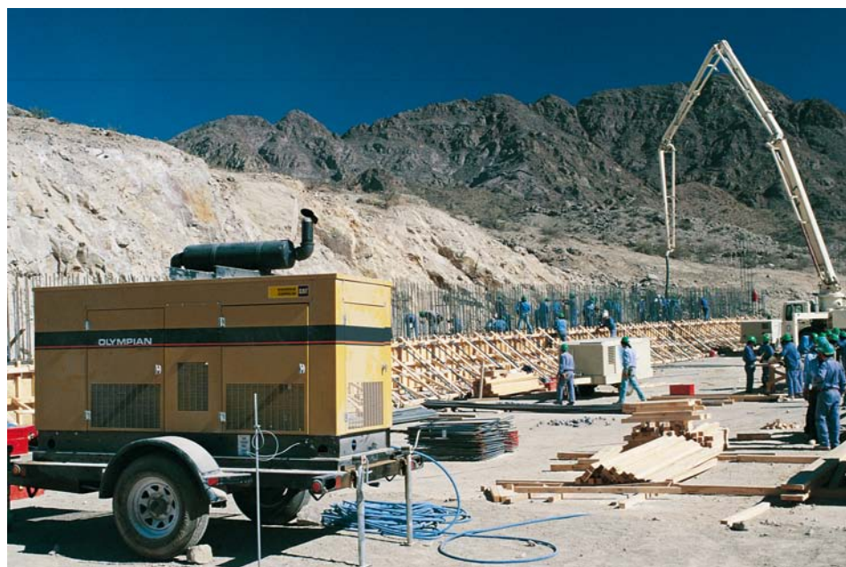
Mobilný generátor s podvozkom je mimoriadne praktický na rozľahlých staveniskách, hlavne pre ľahké presuny a rýchle nasadenie na miesto, kde ho práve potrebujú (ilustračný obrázok).
