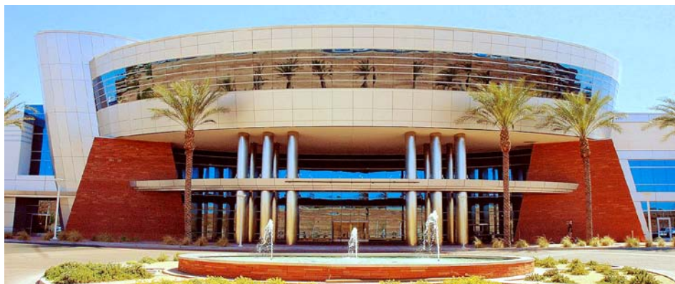
Dátové centrum spoločnosti i/o vo Phoenixe (Arizona, USA) patrí medzi desať najväčších datacentier na svete.
