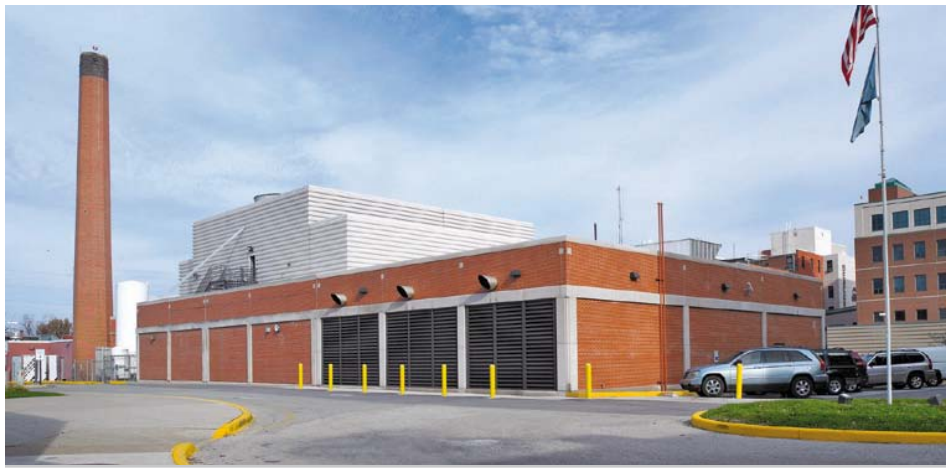
Diecézna nemocnica, traumatické centrum Level 2, v roku 2012 modernizovala záložný zdroj energie, ktorý teraz poskytuje spoľahlivú dodávku elektriny pre životne dôležité zariadenia.
