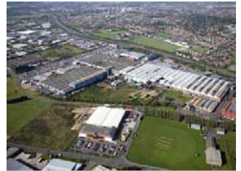
Výrobné priestory Perkins Engines zaberajú až 125 000 m 2 a umožňujú výrobu 500 000 motorov za rok
