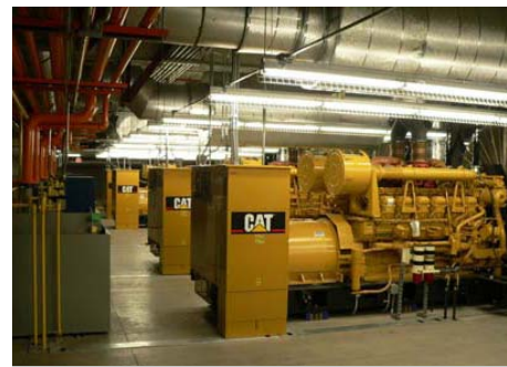
Štyri generátorové sústavy Cat® 3512B s výkonom 1500 kW predstavujú spoľahlivý záložný zdroj elektriny pre potreby významnej univerzitnej nemocnice a regionálnej kliniky.
