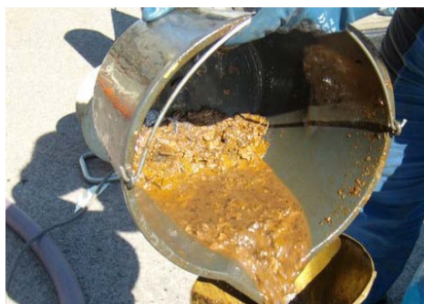
Na záberoch z čistenia palivovej nádrže dieselgenerátora je vidieť dôsledky degradácie biozložky v naftě pri dlhodobom skladovaní. Po vyčistení je možné nádrž naplniť čerstvým palivom.
