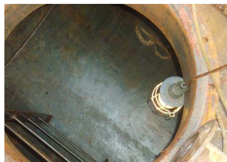
Na záberoch z čistenia palivovej nádrže dieselgenerátora je vidieť dôsledky degradácie biozložky v naftě pri dlhodobom skladovaní. Po vyčistení je možné nádrž naplniť čerstvým palivom.
