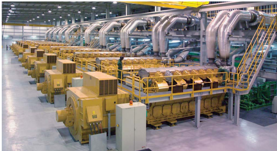
Motory radu CM s 500 – 1000 ot/min sú schopné spaľovať naftu, zemný plyn, ťažké oleje alebo ich kombináciu.
