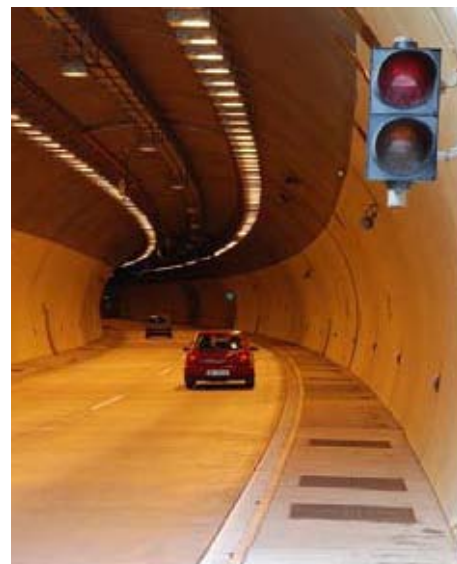
Zeppelin navrhol a inštaloval komplexné riešenie Caterpillar, ktoré sa už osvedčilo v neďalekom tuneli Panenská, najdlhšom tuneli v Česku na diaľnici D8.
