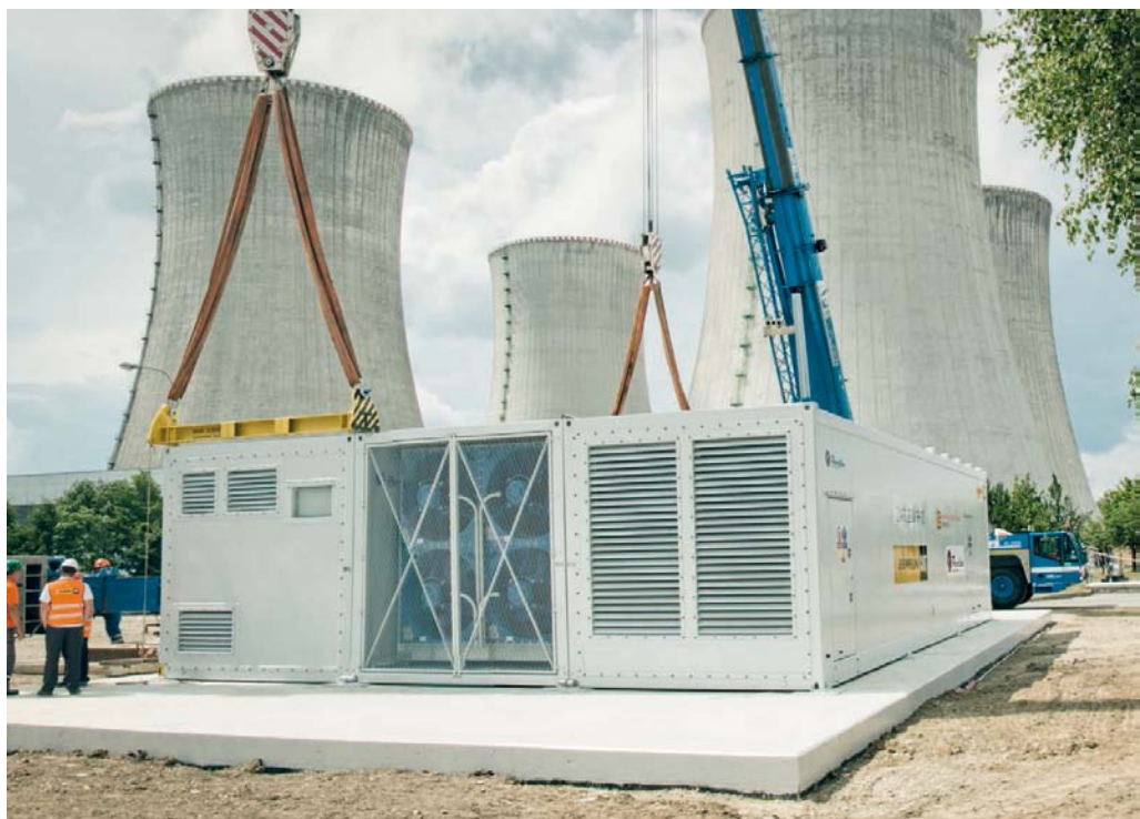
Dieselgenerátorová stanica po osadení na základy spĺňa všetky požiadavky na zariadenia v jadrových elektrárňach.
