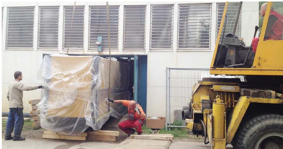
Elektrocentrála GEH275 sa pomocou žeriava presúva do vnútra technickej budovy, kde bude slúžiť.
